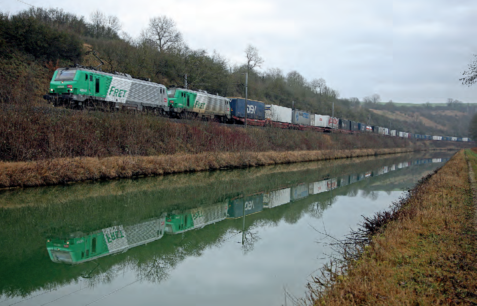
Train d'autoroute ferroviaire sur la liaison Bettembourg – Le Boulou.
